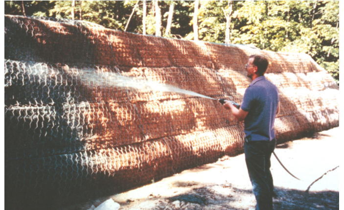
Figura 1 - Aplicación de la hidrosiembra sobre el paramento frontal de la estructura Terramesh® Verde.
