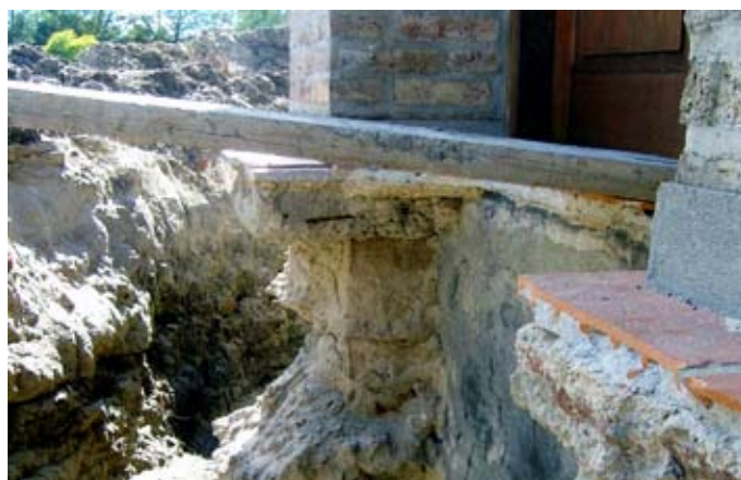
Durante la obra
