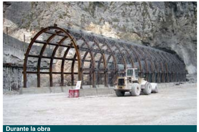
Durante la obra
