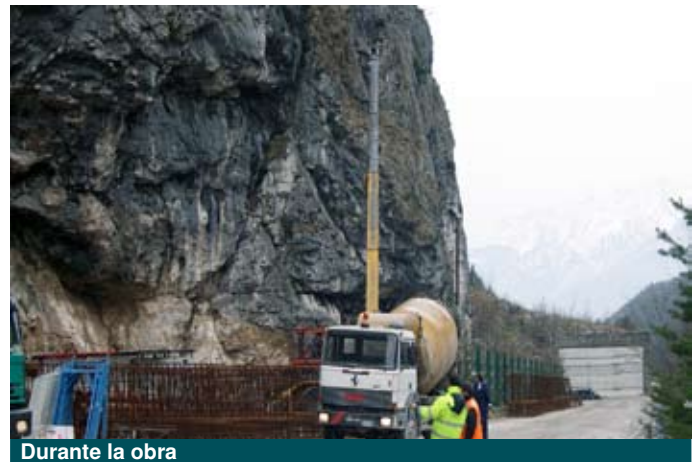
Durante la obra
