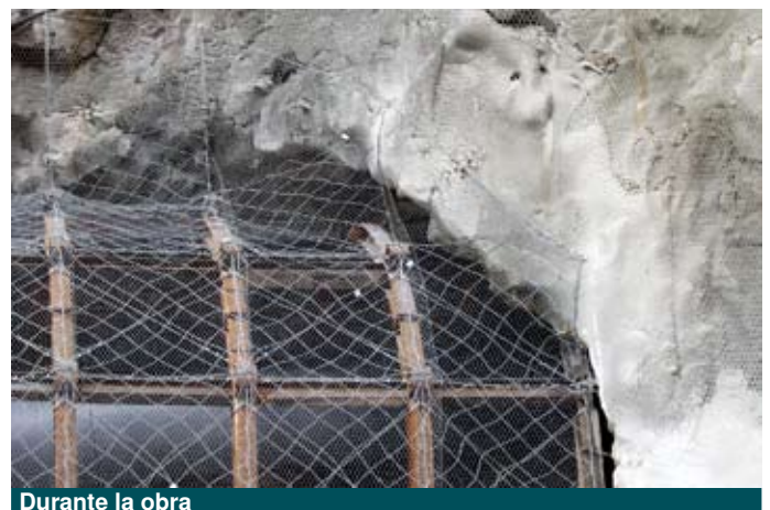
Durante la obra
