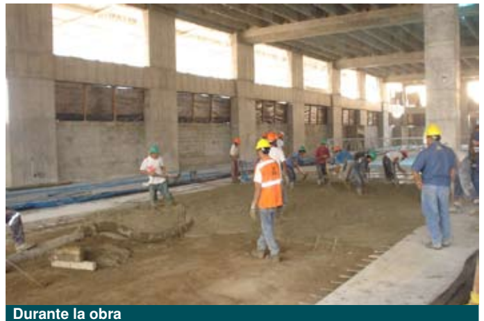
Durante la obra
