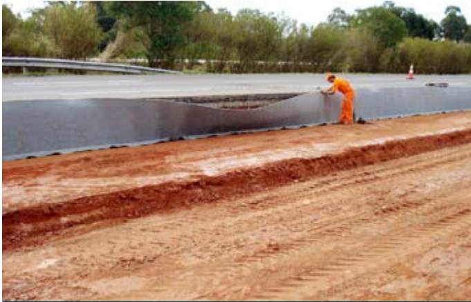
Durante la obra
