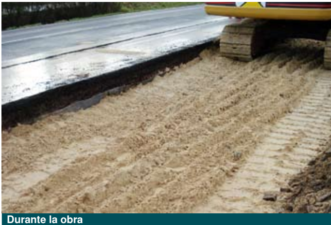
Durante la obra
