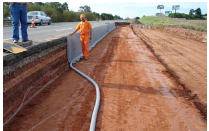
Durante la obra
