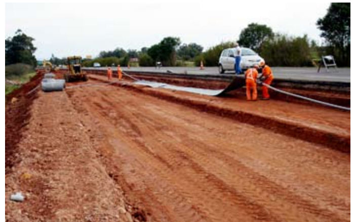
Durante la obra
