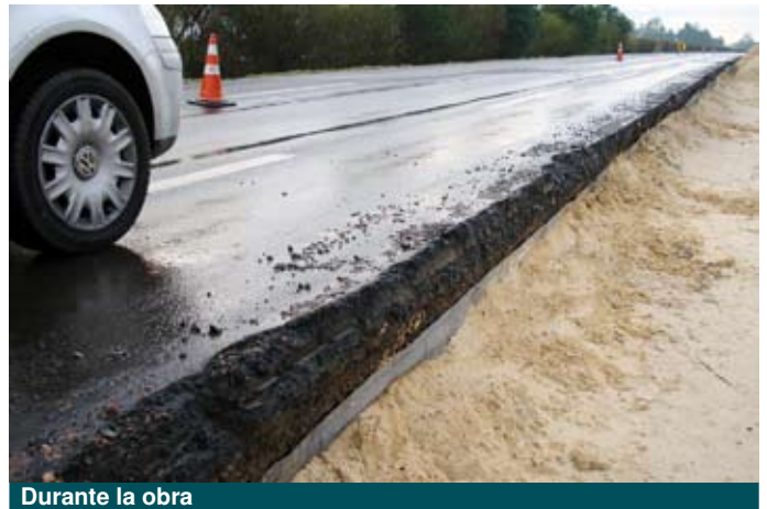
Durante la obra
