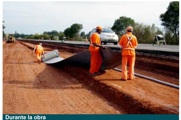
Durante la obra
