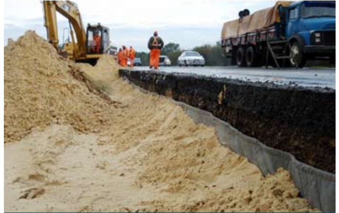
Durante la obra
