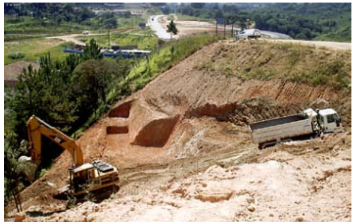
Durante la obra
