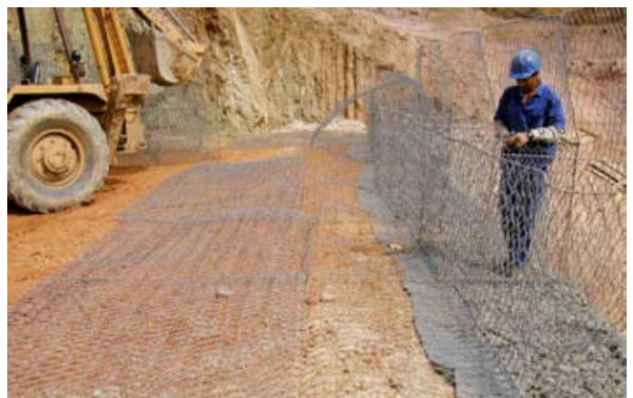
Durante la obra
