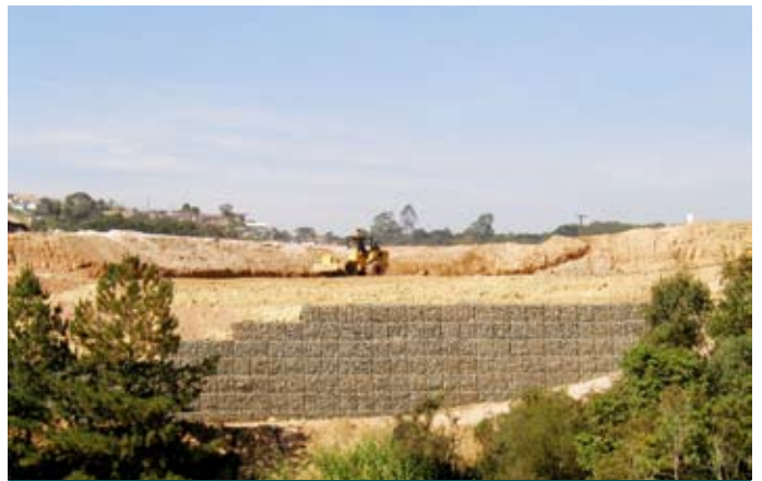
Durante la obra
