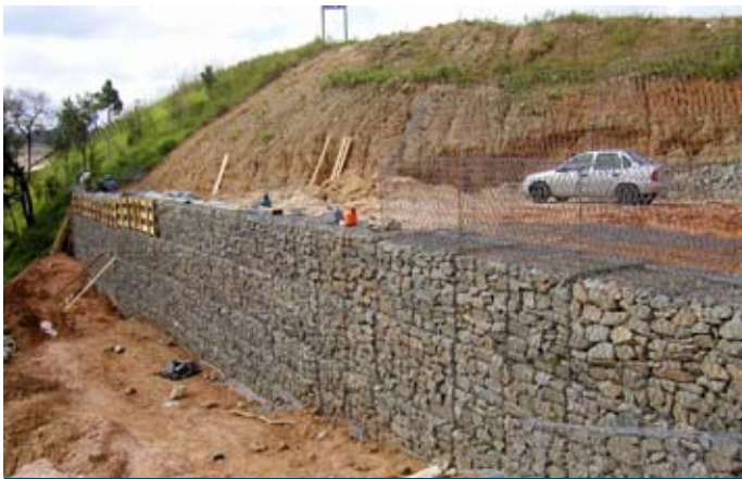
Durante la obra
