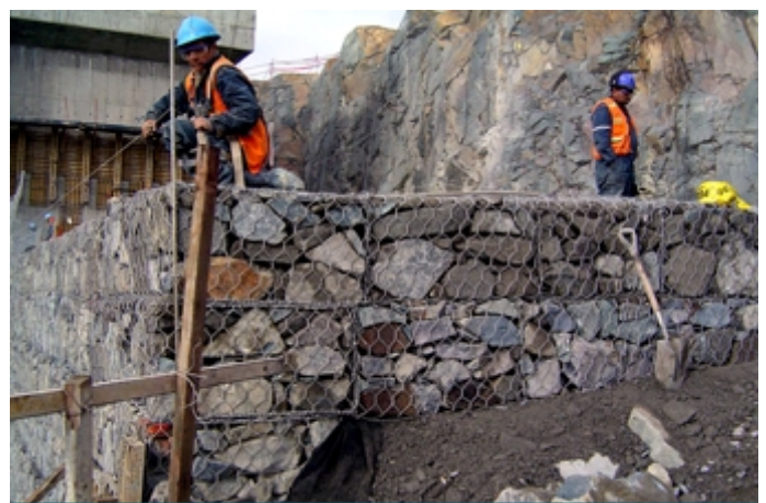
Durante la Construcción
