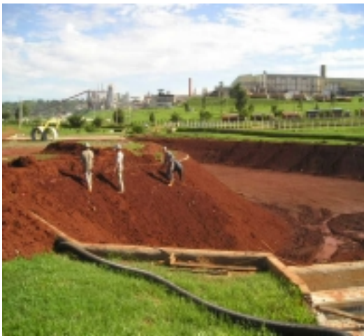
Figura 1 – Preparación del terreno
