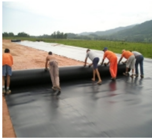
Figura 2 – Instalación de la geomembrana
