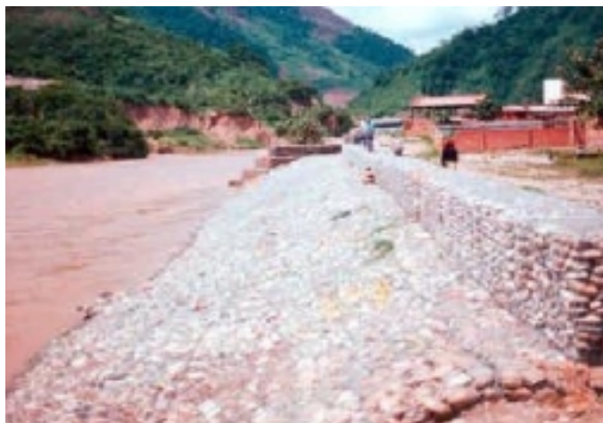
Plataforma de deformación en colchón Reno
