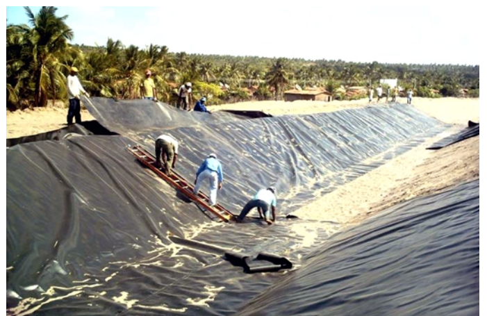
Durante la construcción
