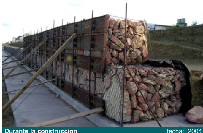
Durante la construcción
