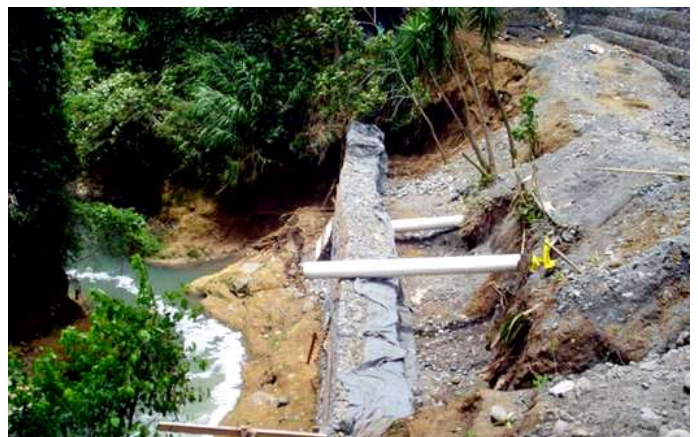
Durante la Construcción
