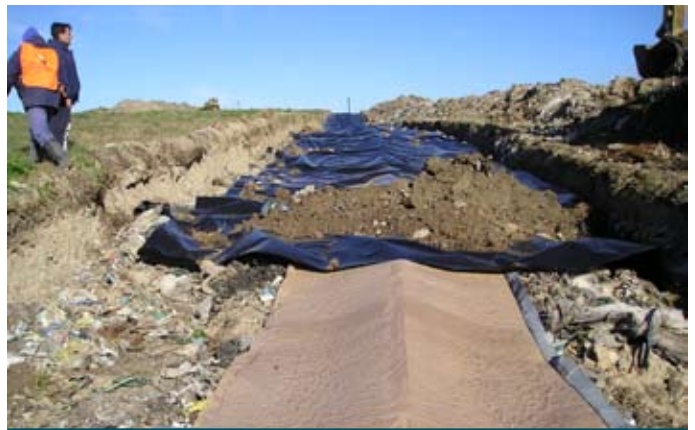
Aplicación del suelo de cobertura
