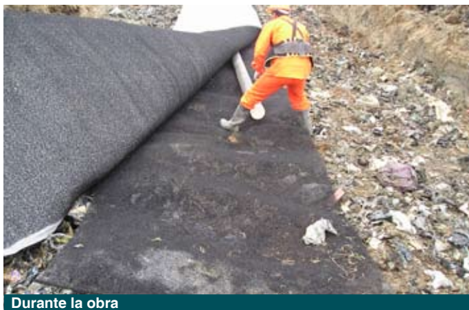
Aplicación de la geomembrana
