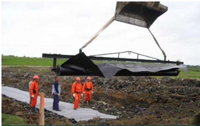
Aplicación de la geomembrana
