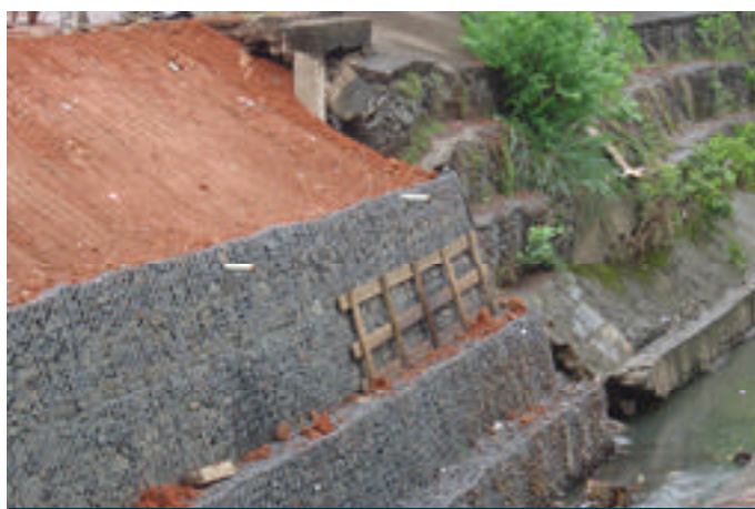
Durante la construcción
