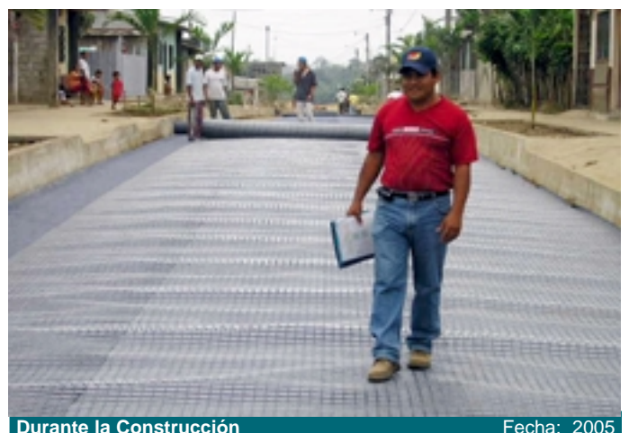
Durante la Construcción
