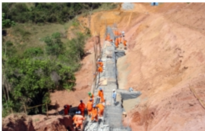
Durante la Construcción
