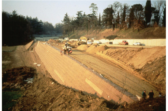
Figura 2. Terramesh® Verde em construção.
