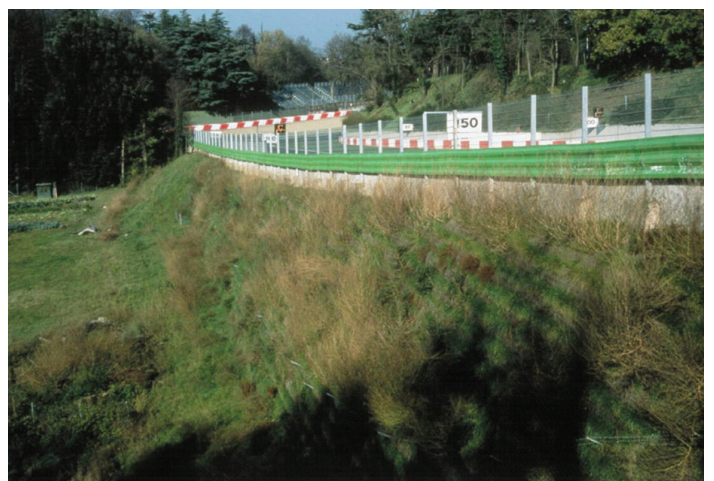
Figura 4. Terramesh® Verde com vegetação plenamente desenvolvida.
