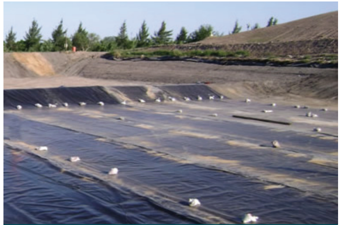
Durante a obra
