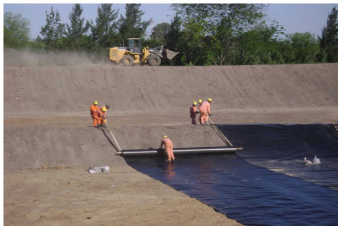
Durante a obra
