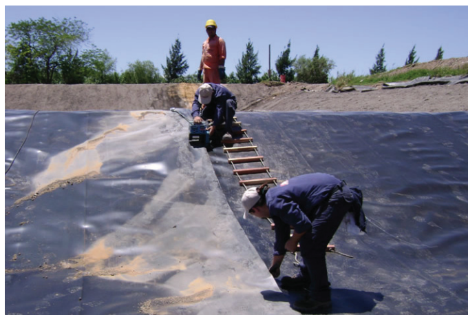
Durante a obra
