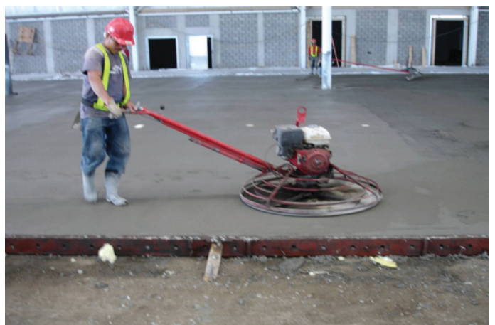
Durante a obra
