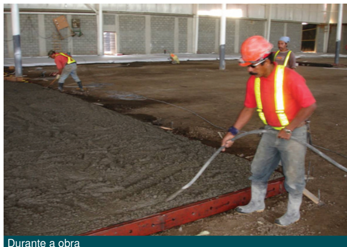
Durante a obra
