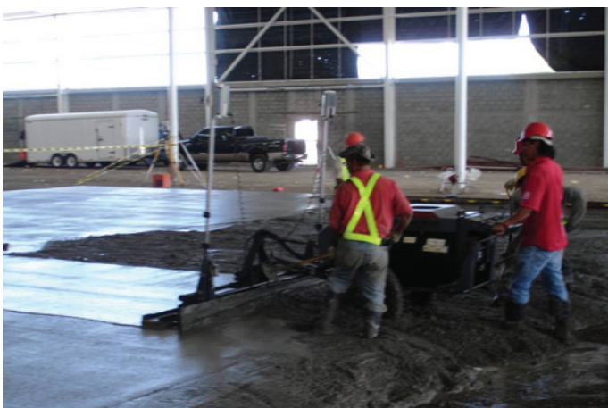
Durante a obra
