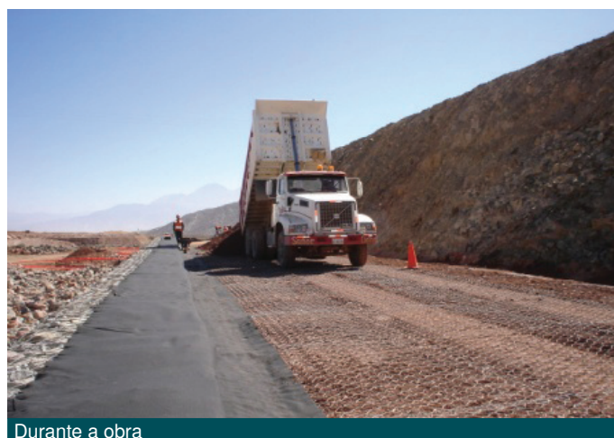
Durante a obra
