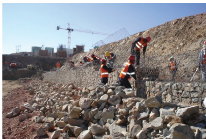
Durante a obra
