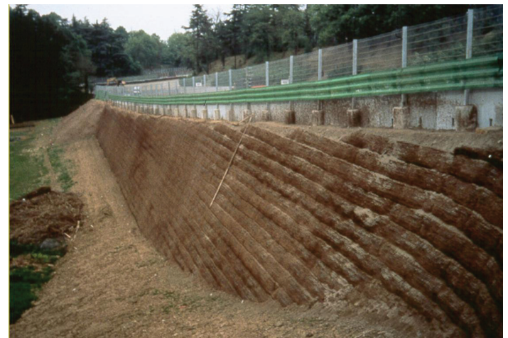
Figura 3. Terramesh® Verde después de término.
