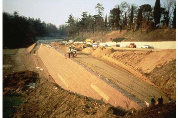
Figura 2. Terramesh® Verde en construcción.
