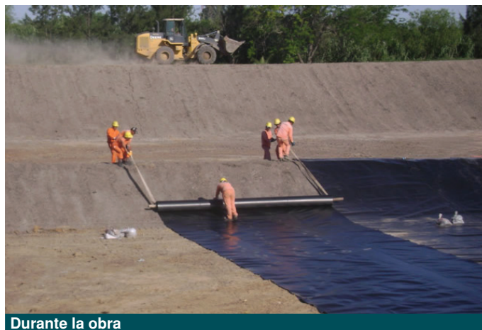
Durante la obra
