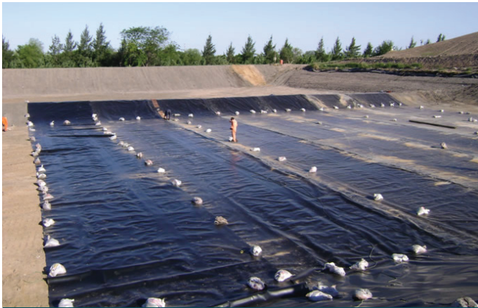
Durante la obra
