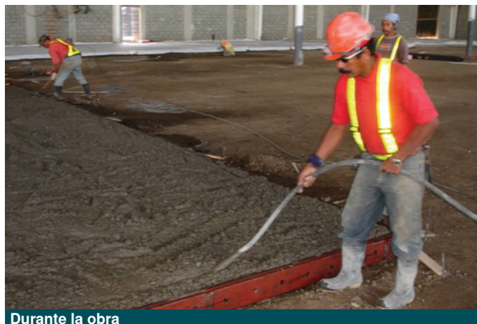
Durante la obra
