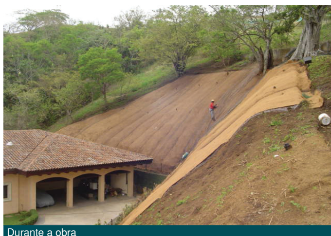
Durante a obra
