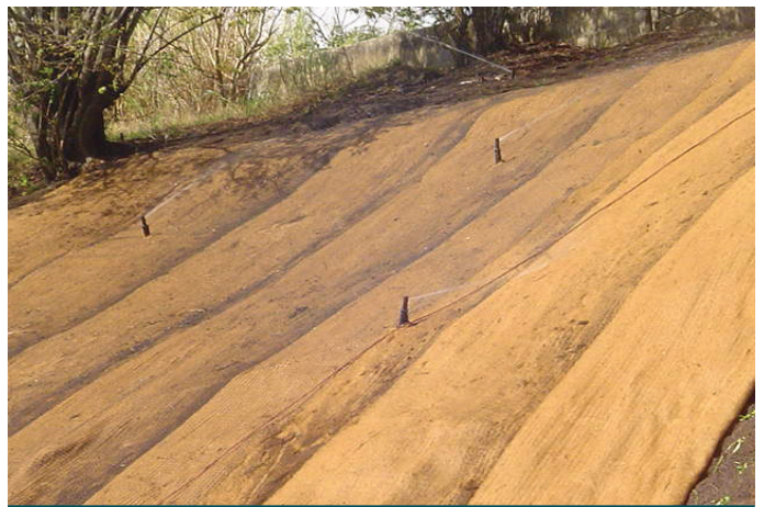
Durante a obra
