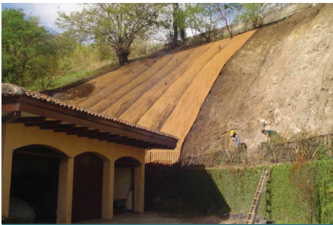
Durante a obra
