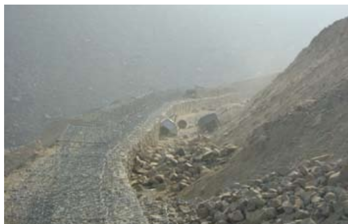
Durante a obra
