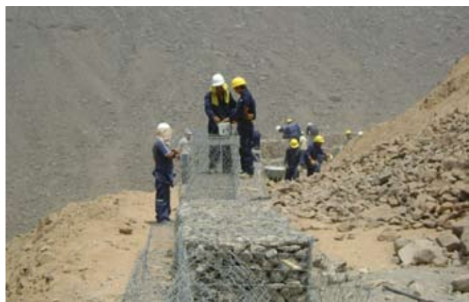
Durante a obra
