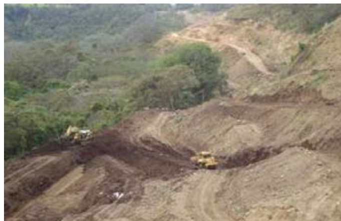
Durante a obra
