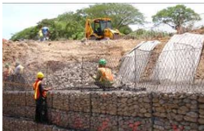
Durante a obra
