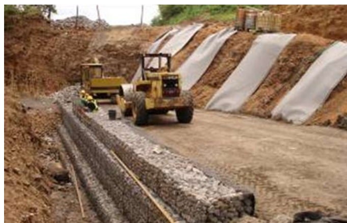
Durante a obra
