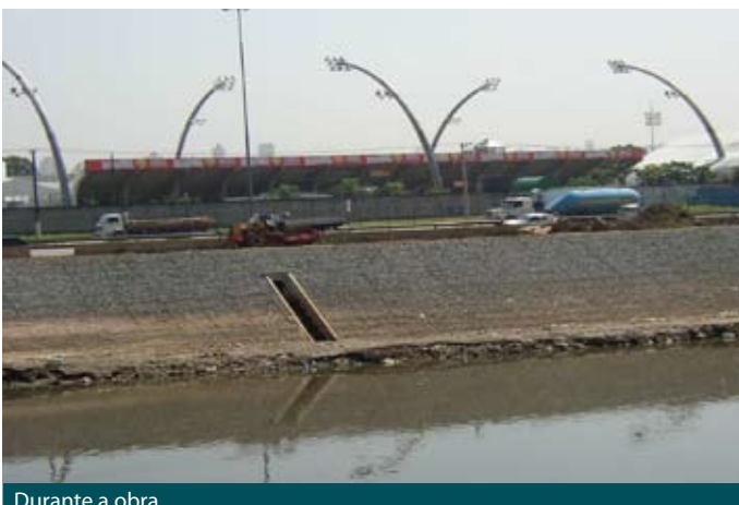
Durante a obra
