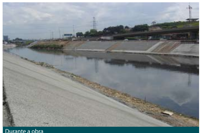
Durante a obra
