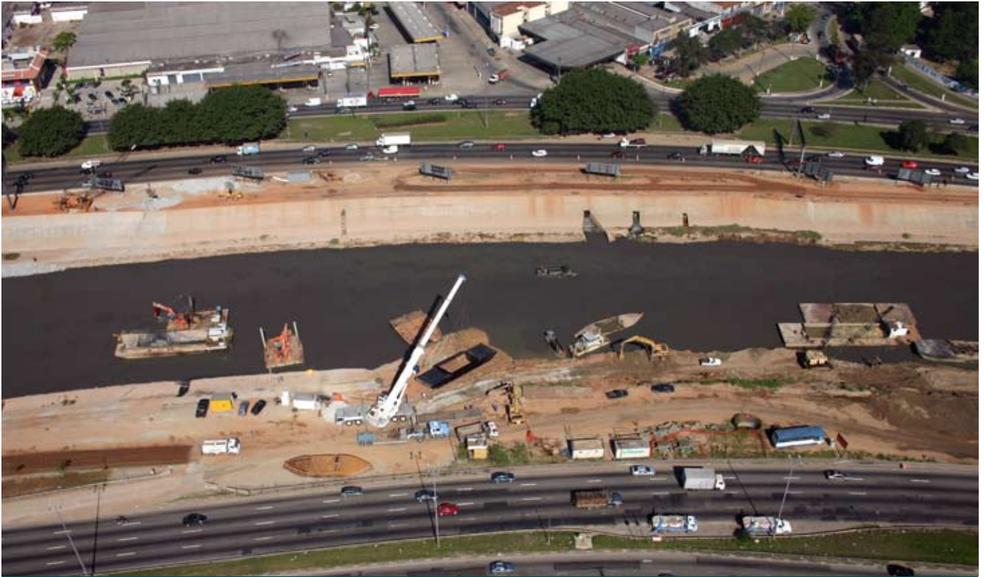
Durante a obra
