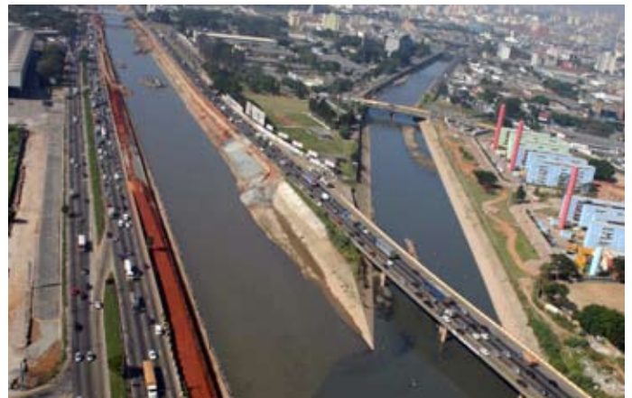
Durante a obra
