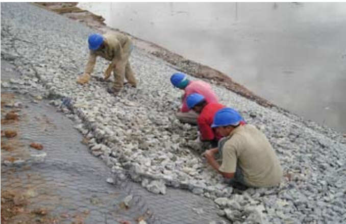
Durante a obra
