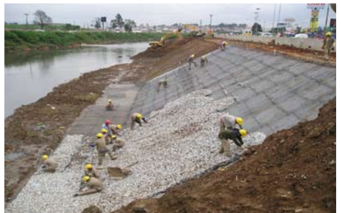
Durante a obra
