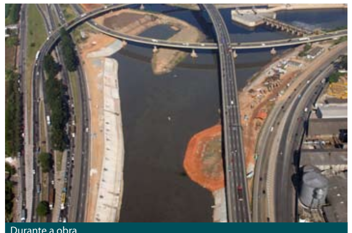
Durante a obra
