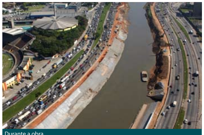
Durante a obra
