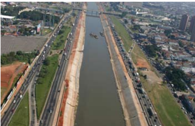
Durante a obra
