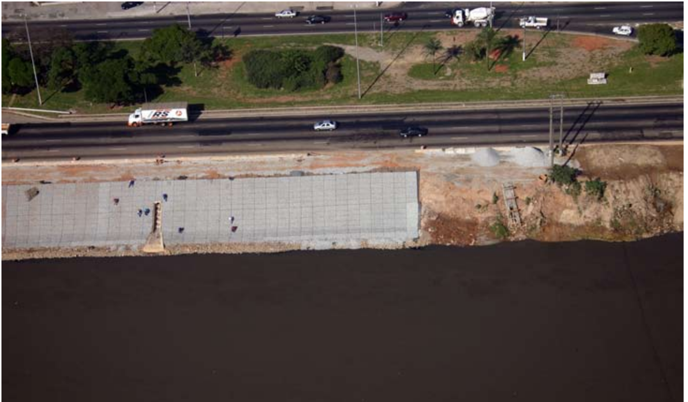
Durante a obra
