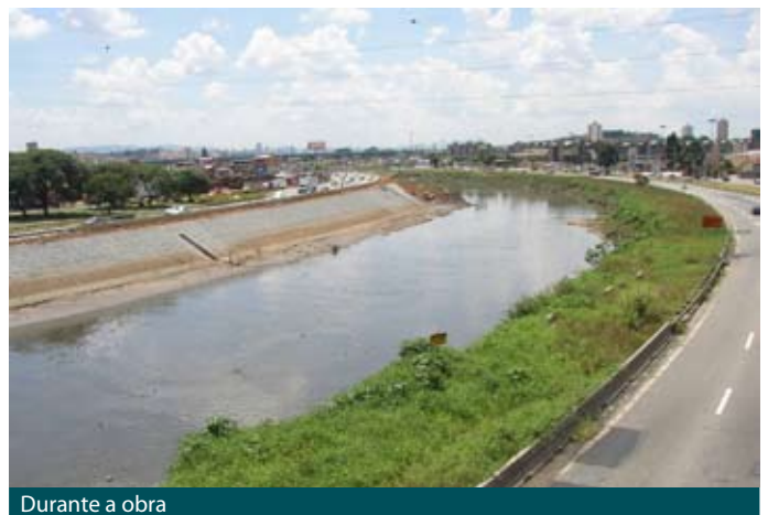
Durante a obra
