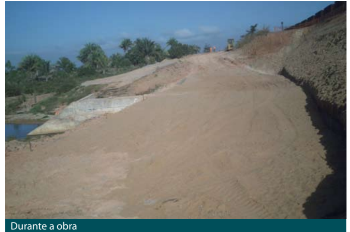
Durante a obra
