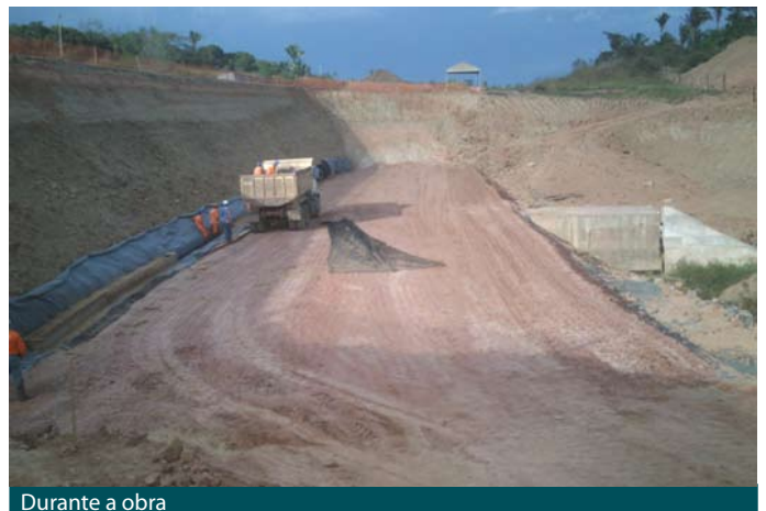
Durante a obra
