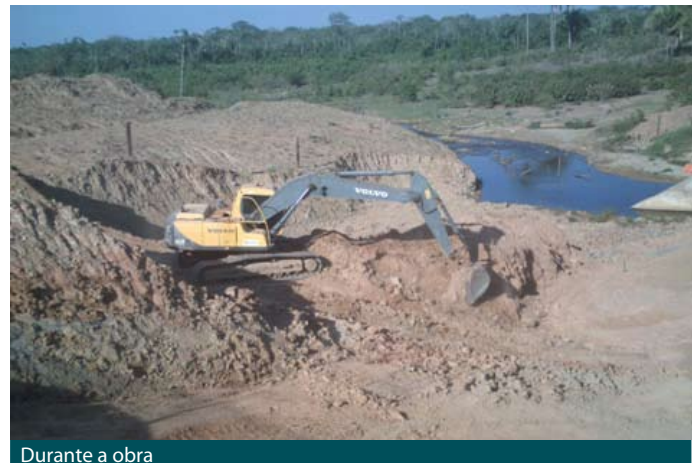
Durante a obra
