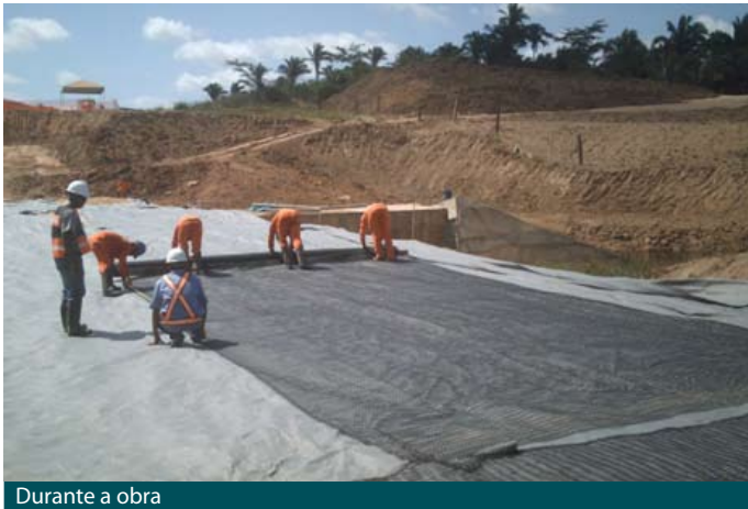
Durante a obra
