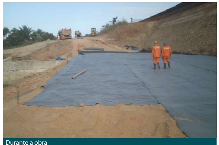
Durante a obra
