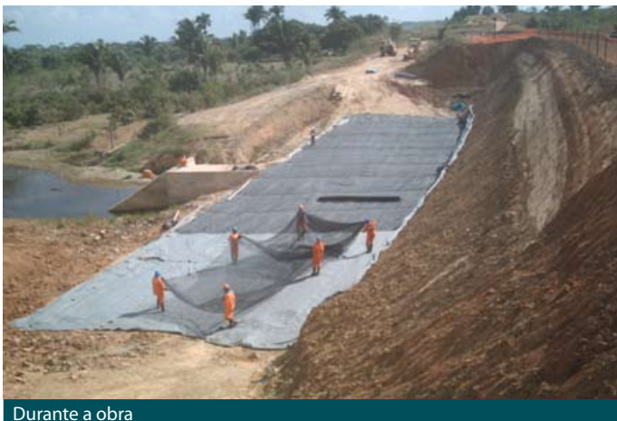
Durante a obra
