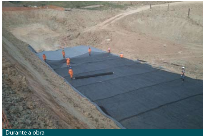
Durante a obra
