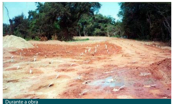
Durante a obra
