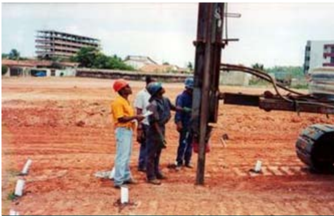
Durante a obra
