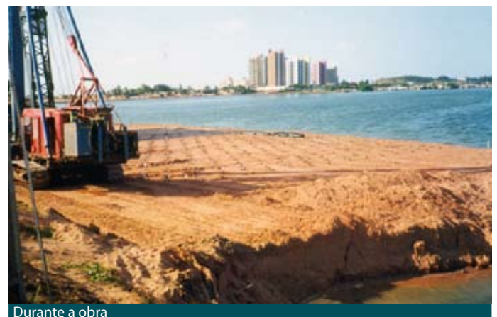
Durante a obra
