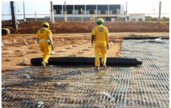
Durante a obra
