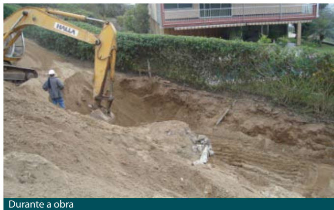
Durante a obra
