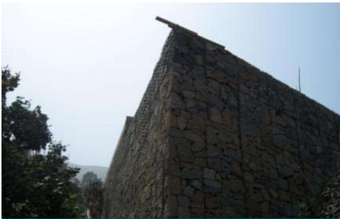
Durante a obra
