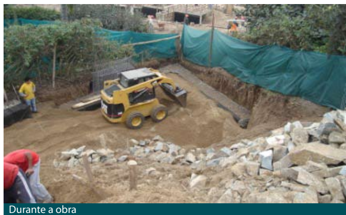
Durante a obra
