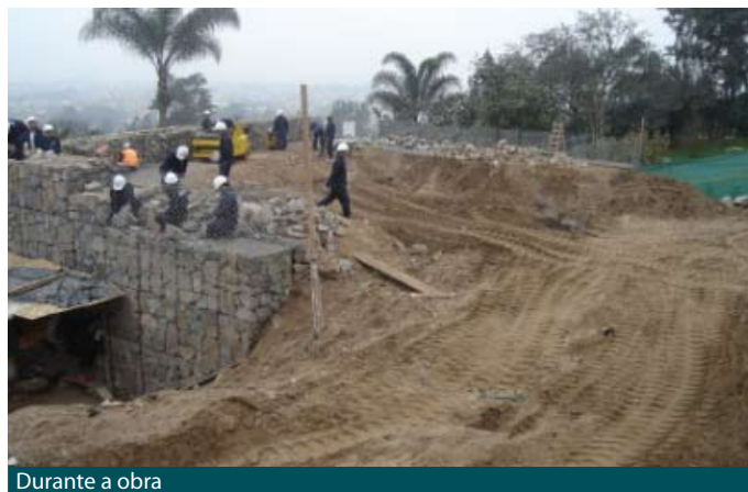
Durante a obra
