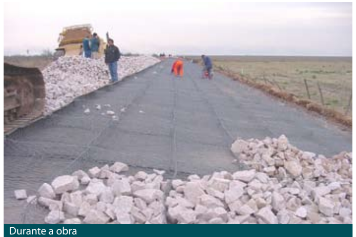
Durante a obra
