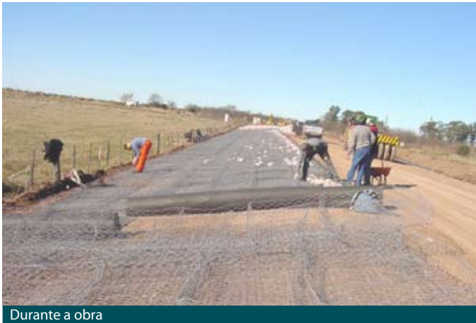
Durante a obra
