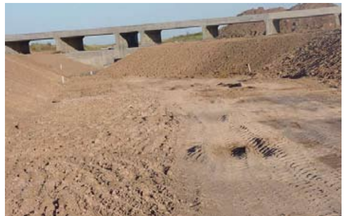
Durante a obra
