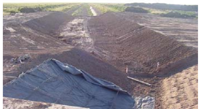
Durante a obra
