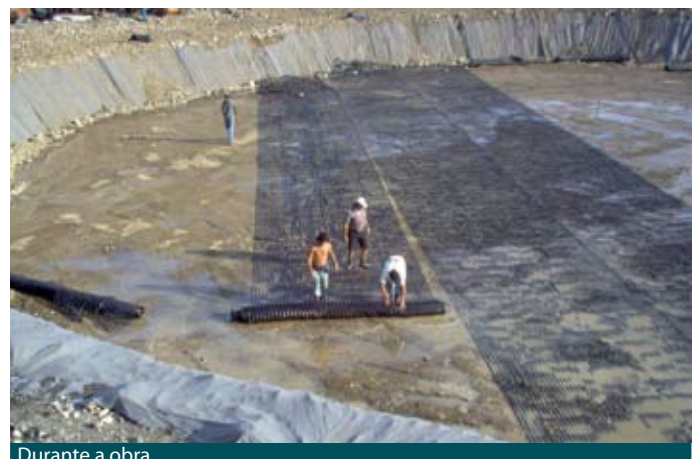
Durante a obra
