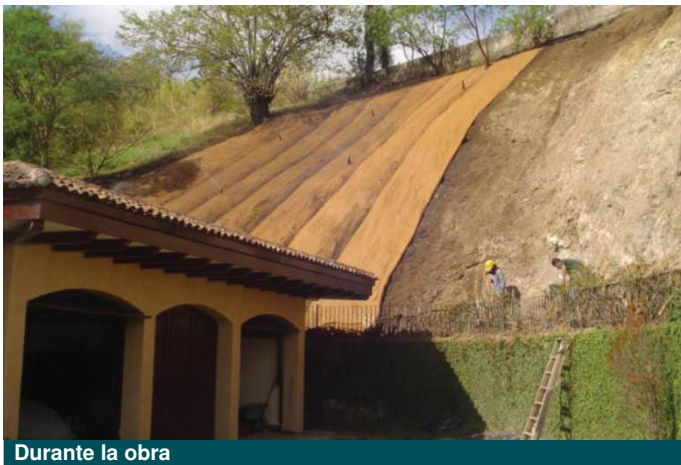
Durante la obra
