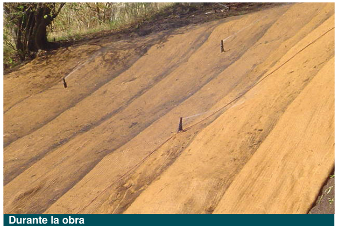
Durante la obra
