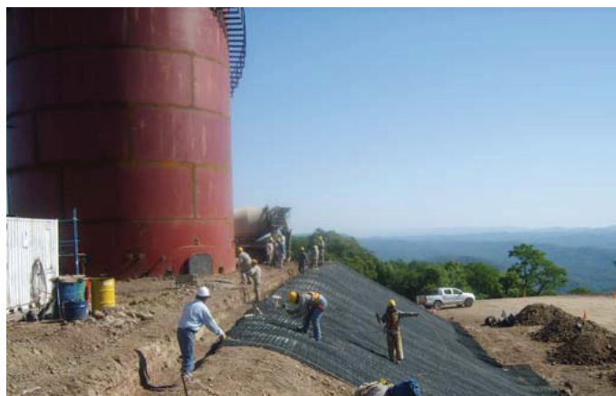
Durante la obra
