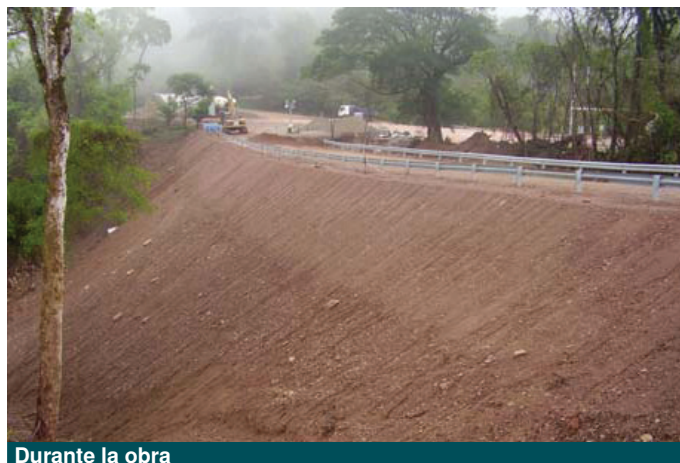
Durante la obra
