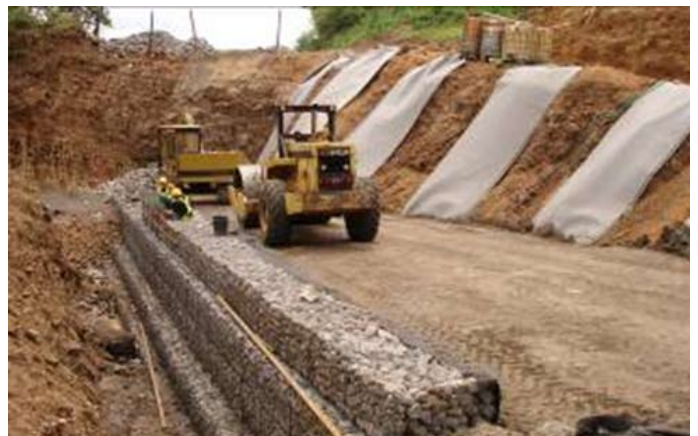
Durante la obra
