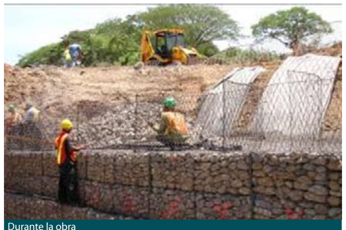
Durante la obra
