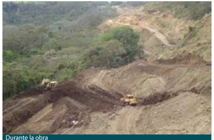
Durante la obra
