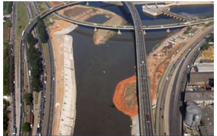
Durante la obra
