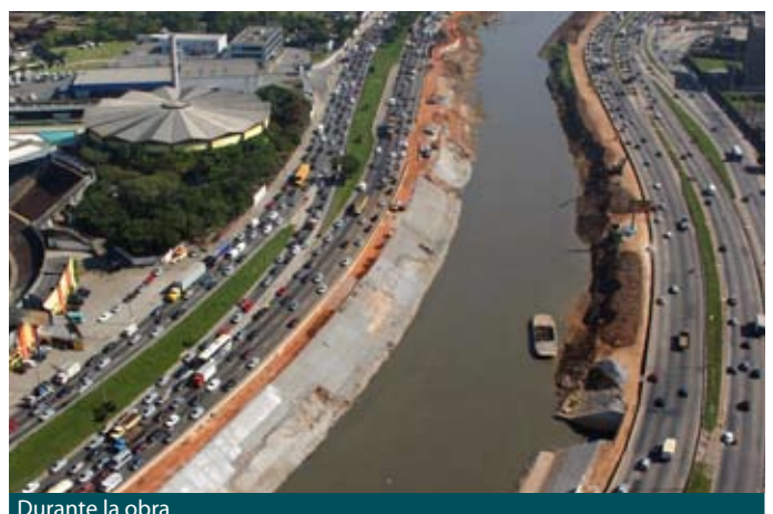
Durante la obra
