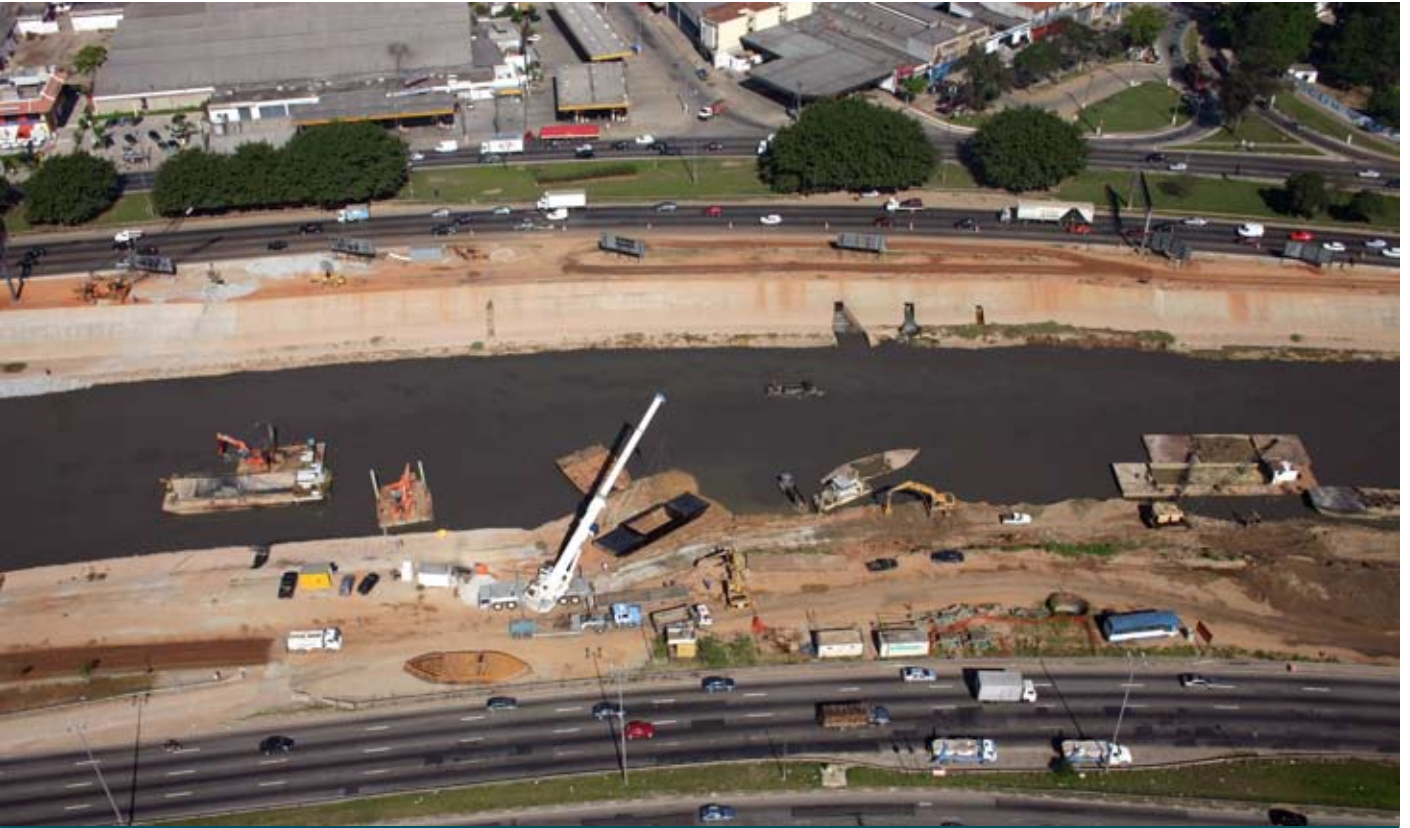
Durante la obra
