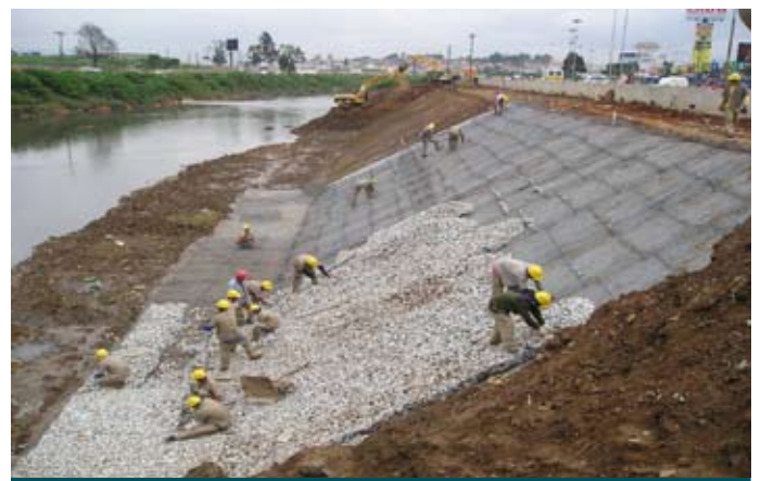
Durante la obra
