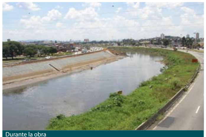
Durante la obra
