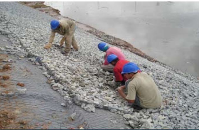
Durante la obra
