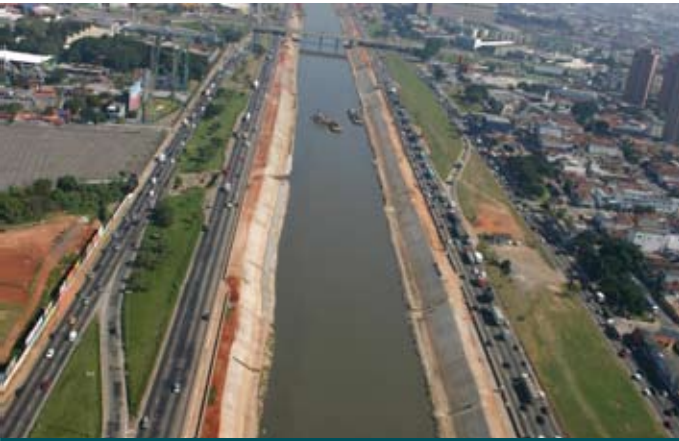
Durante la obra
