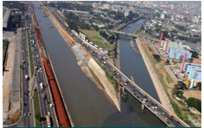
Durante la obra
