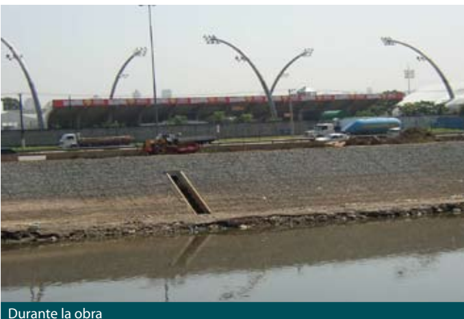
Durante la obra
