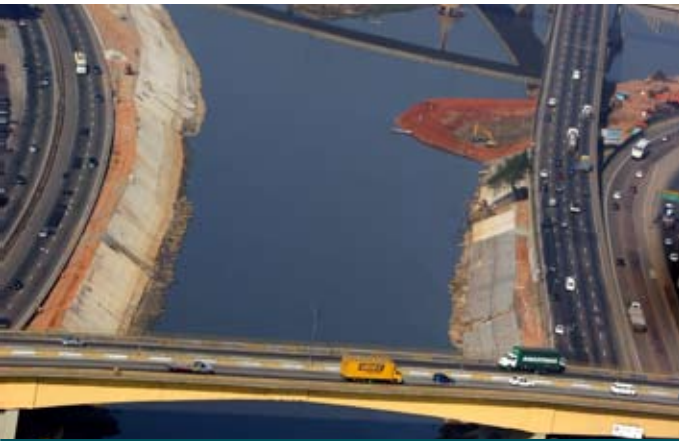
Durante la obra
