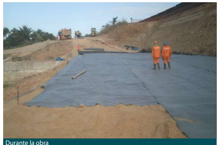
Durante la obra
