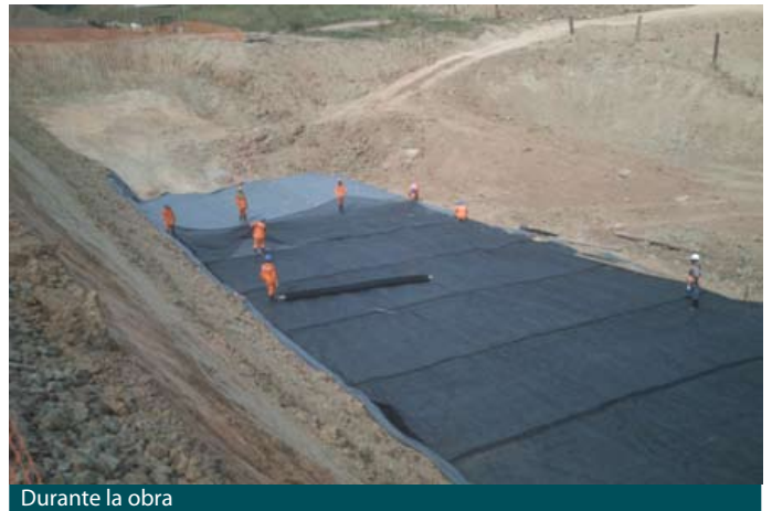
Durante la obra
