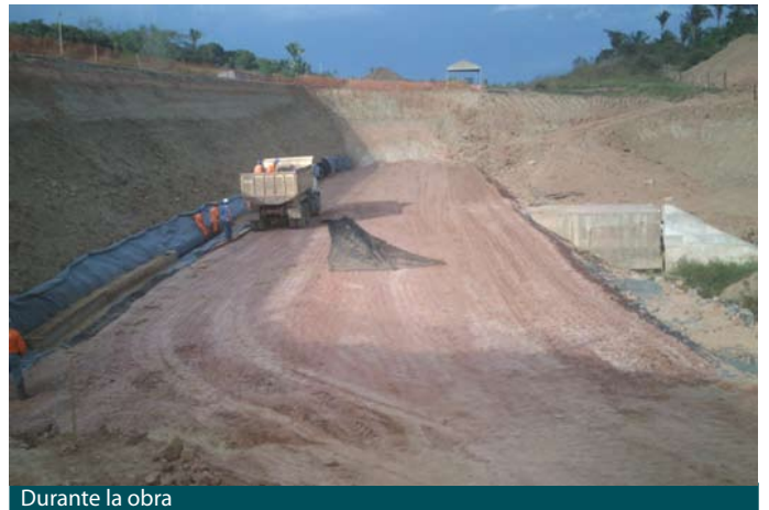
Durante la obra
