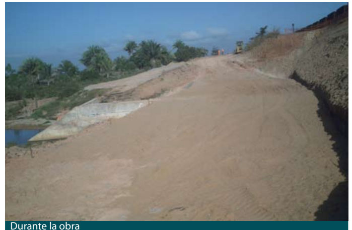
Durante la obra
