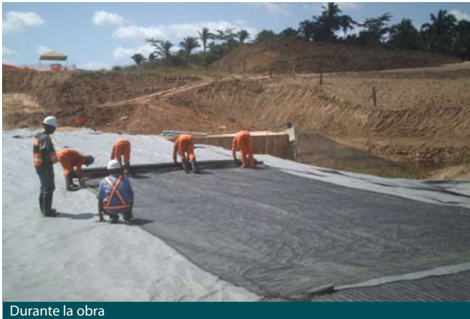
Durante la obra
