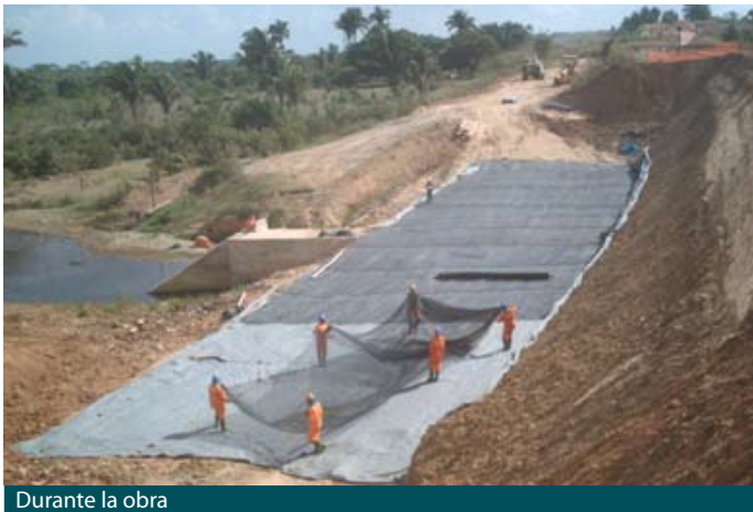
Durante la obra
