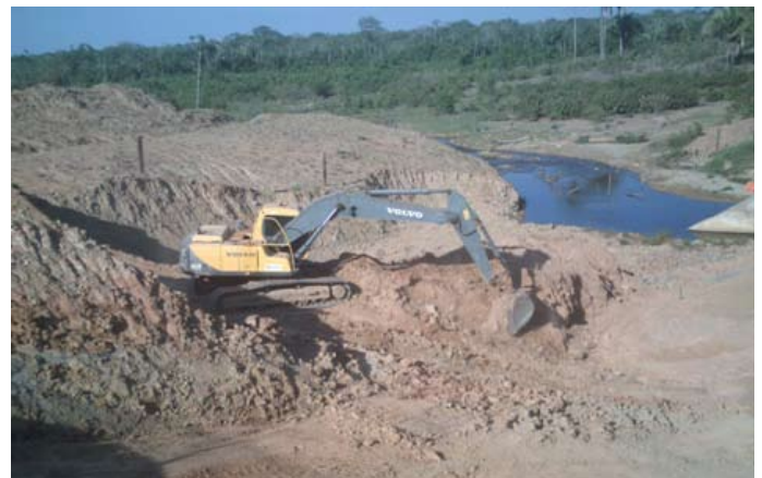
Durante la obra
