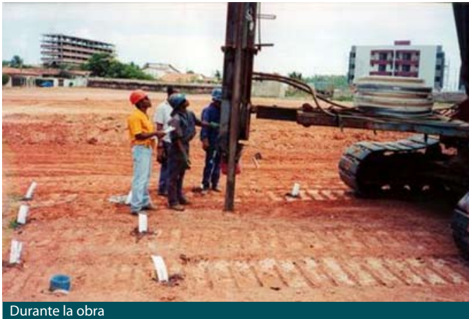
Durante la obra
