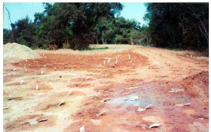
Durante la obra
