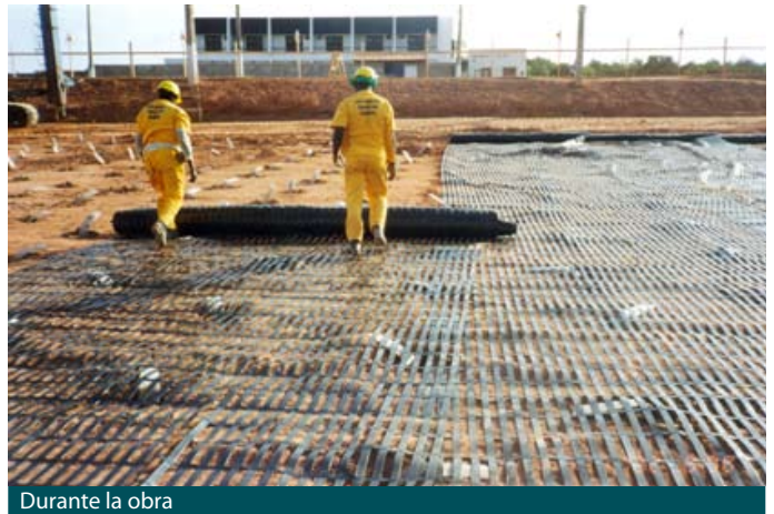
Durante la obra
