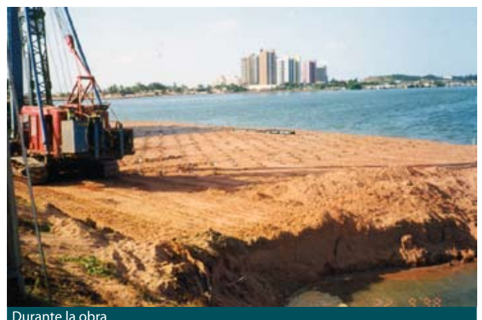
Durante la obra
