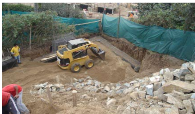
Durante la obra
