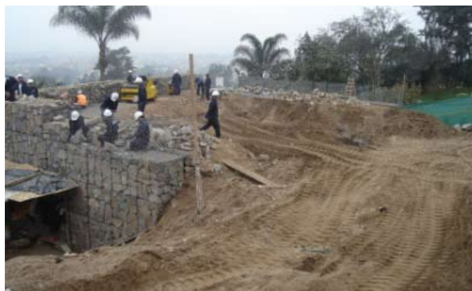
Durante la obra
