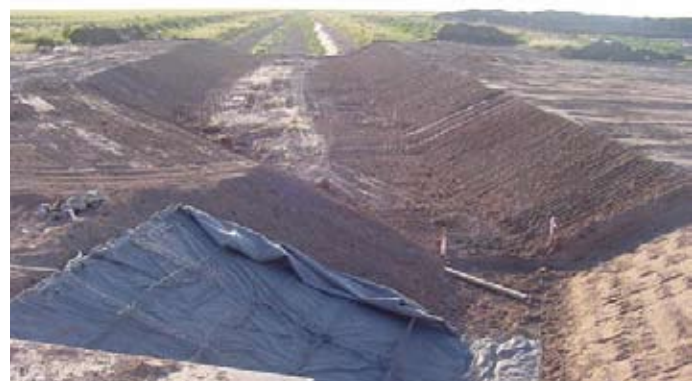
Durante la obra
