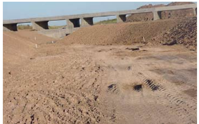
Durante la obra
