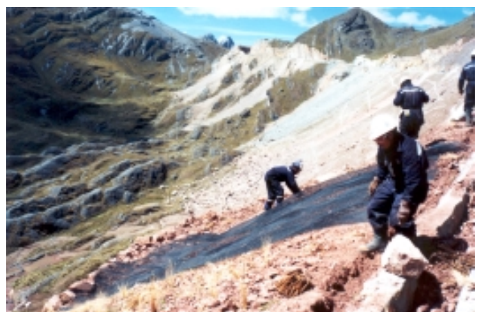
Durante la Construcción
