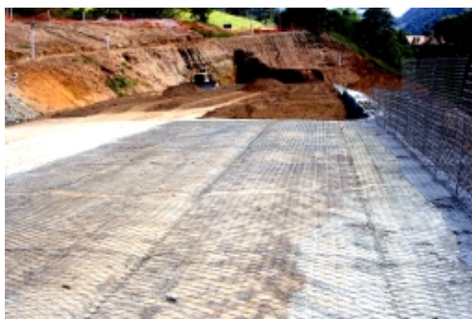
Durante la Construcción
