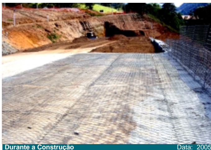
Durante a Construção
