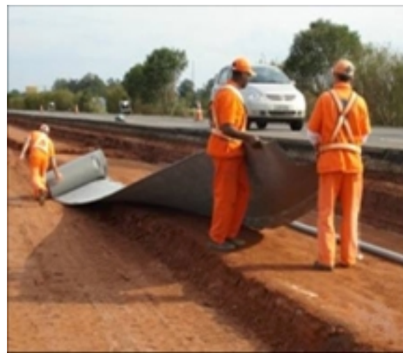
Figura 07. Abertura do rolo do geocomposto
