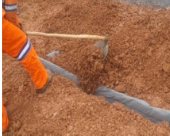
Figura 08. Colocação do geocomposto na vala. I Figura 09. Reaterro manual das trincheiras.
