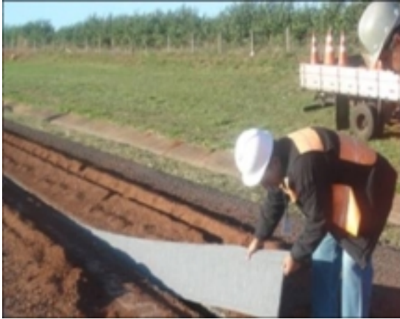
Figura 08. Colocação do geocomposto na vala. I Figura 09. Reaterro manual das trincheiras.
