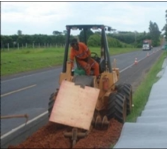
Figura 06. Escavação da trincheira
