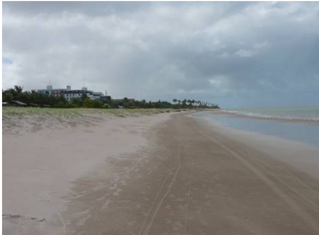
Figura 09. Obra quatorze anos após sua conclusão.
