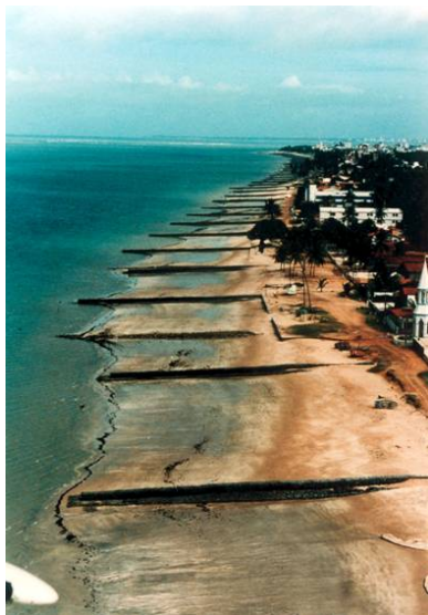
Figura 07. Imagem aérea da obra três meses após o seu término.
